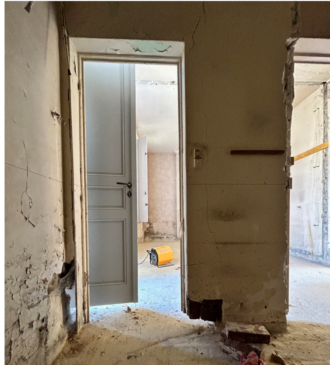
RDJ - la cloison en pan de bois séparative entre l'entrée et la future salle d'eau sera rebouchée au droit du mur de façade et renforcée.
