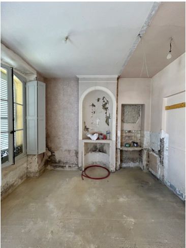
RDJ - Le projet prévoit l'aménagement d'une séquence d'entrée dans l'axe de la porte d'accès au T2 et d'une chambre orientée vers le jardin sur rue. Les revêtements de sol seront posés sur la chape existante. Un faux plafond acoustique sera posé sur l'ensemble du PHRDJ. Une gorge permettra d'intégrer le rideau de la chambre.
