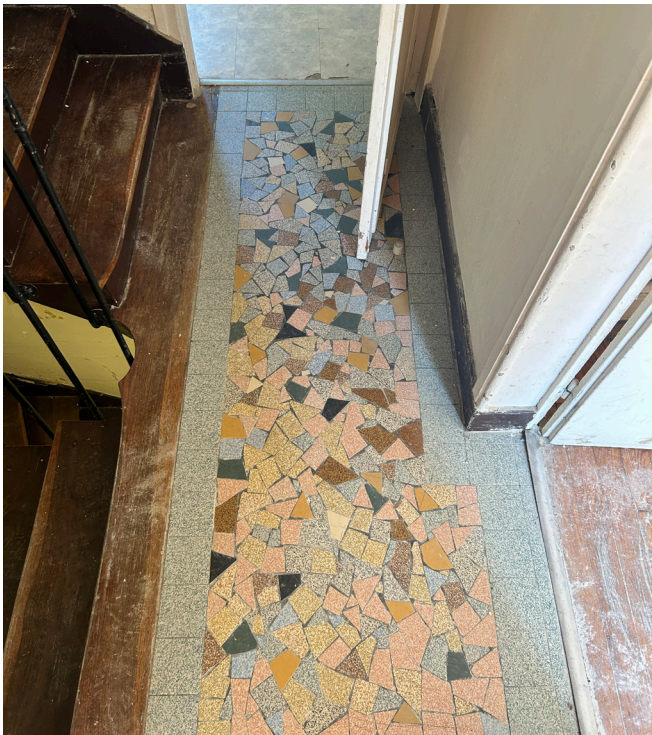
R+1 - Une lasure de protection sur le sol existant du palier sera mise en oeuvre
