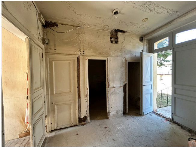
RDJ - La cloison en pan de bois séparative entre l'entrée et la future salle d'eau sera rebouchée au droit du mur de façade et renforcée. La porte donnant sur l'escalier sera déposée et l'ouverture rebouchée. On aperçoit sur la gauche la porte double ventaux identifiée comme d'intérêt par la DRAC. Elle sera restaurée.
