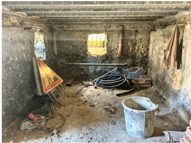
Cave - Plancher haut béton sur poutrelles hourdis construit dans le cadre des travaux de l'ACMH. Le projet prévoit l'isolation par flocage en sous face du plancher haut.
