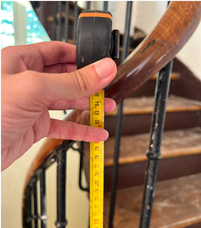
RDJ - L'escalier du T3 est, lui aussi, identifié par la DRAC comme ouvrage d'intérêt et sera restauré. Sa géométrie sera conservée, bien que sa main courante, basse, et le vide entre barreaux verticaux, large, ne soient pas conforme à la réglementation en vigueur. Nous demandons à ce titre, et compte tenu de sa qualité identifiée, une dérogation réglementaire.
