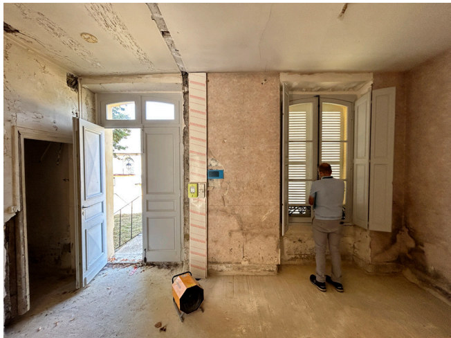
RDJ - Le projet prévoit l'aménagement d'une séquence d'entrée dans l'axe de la porte d'accès au T2 et d'une chambre orientée vers le jardin sur rue. Les revêtements de sol seront posés sur la chape existante. Un faux plafond acoustique sera posé sur l'ensemble du PHRDJ. Une gorge permettra d'intégrer le rideau de la chambre.
