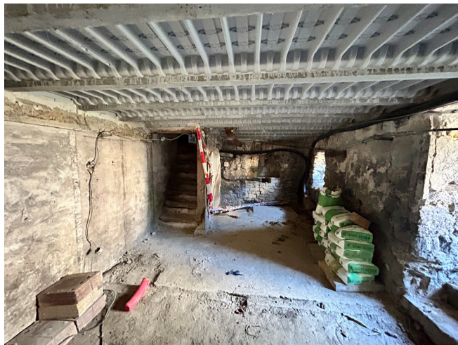
Cave - Plancher haut béton sur poutrelles hourdis construit dans le cadre des travaux de l'ACMH. Le projet prévoit l'intervention antiparasitaire sur l'escalier d'accès situé au fond de la cave et l'isolation par flocage en sous face du plancher haut.
