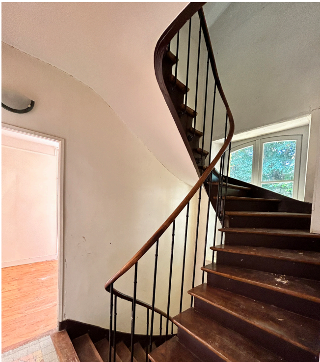
R+1 - L'encloisonnement de l'escalier sera doublé sur toute la hauteur de la trémie pour isoler phoniquement et thermiquement les logements.
